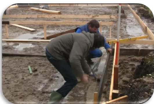
Foto 5: Het nieuwe bijgebouw wordt uitgezet
