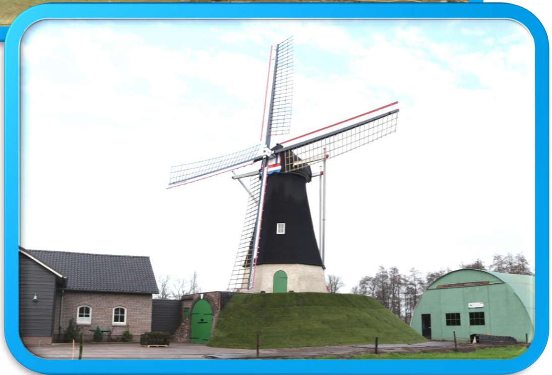
Foto 43 en 44: Het bijgebouw en de molenromp voor en na de restauratie
