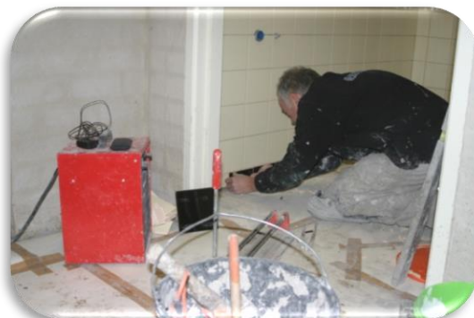
Foto 13: De toiletruimte wordt betegeld
