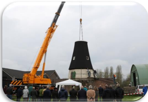
Foto 35: De achtkant wordt op de romp gehesen
