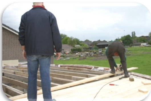
Foto 15: De bekisting voor het nieuwe betonnen dak
