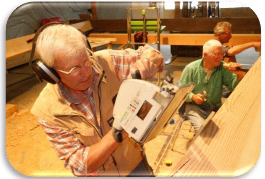
Foto 28: Bouwvrijwillgers zagen, schaven en hakken
