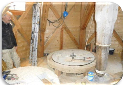
Foto 41: Het maalmechaniek wordt geïnstalleerd
