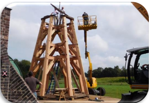
Foto 33: De achtkant wordt naast de romp opgebouwd
