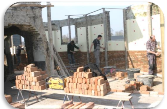
Foto 12: Metselen aan de molenromp
