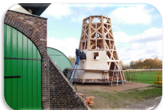
Foto 34: De achtkant wordt naast de romp opgebouwd
