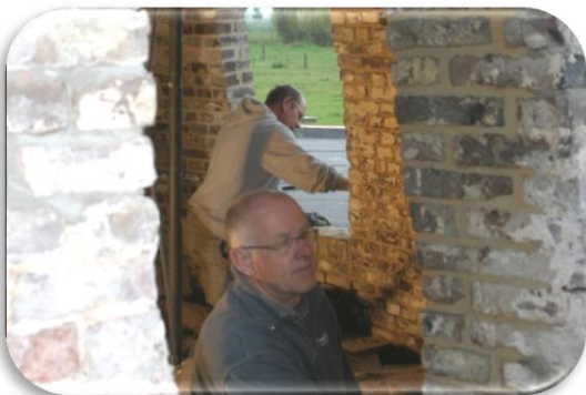
Foto 21: Het voegwerk van de molenromp wordt hersteld
