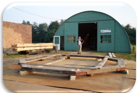
Foto 32: De achtkant wordt naast de romp opgebouwd
