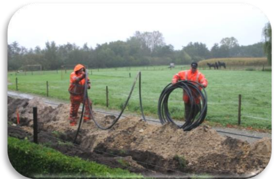
Foto 22: De nutsvoorzieningen worden aangelegd
