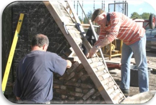
Foto 19: Een van de steunberen wordt gerepareerd
