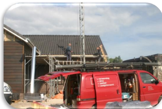
Foto 10: De pannen zijn gelegd
