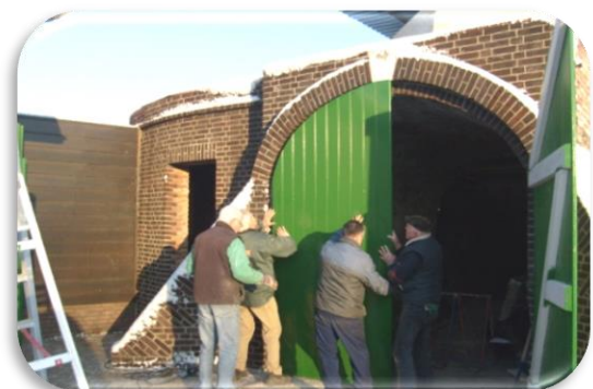
Foto 26: Nieuwe deuren in de inrijpoort
