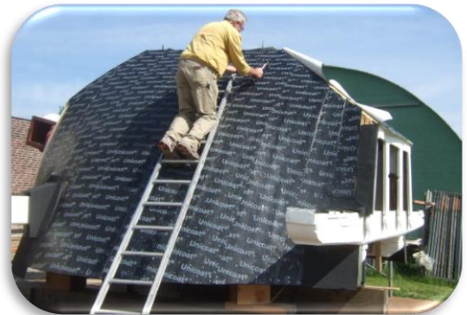
Foto 38: De kap wordt voorzien van dakleer
