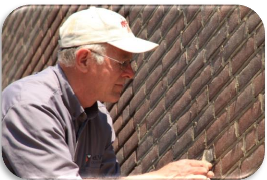
Foto 9: Het aanbrengen van knipvoegen
