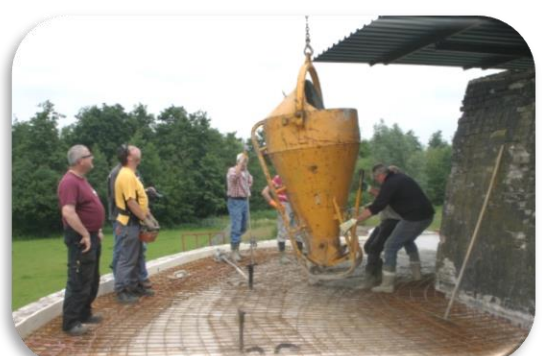
Foto 16: Het nieuwe dak wordt gestort
